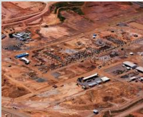
Imagem aérea do site
