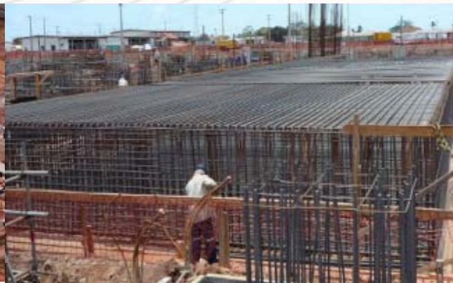
Construção Civil (Base dos Compressor)
